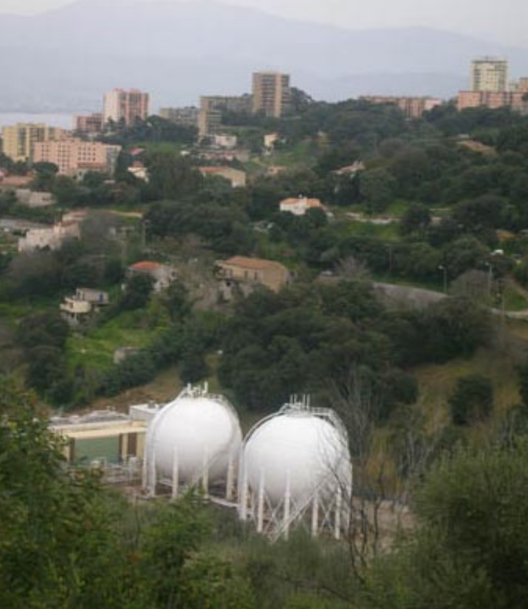
Sphères de butane du site industriel de Gaz de France (Ajaccio)
